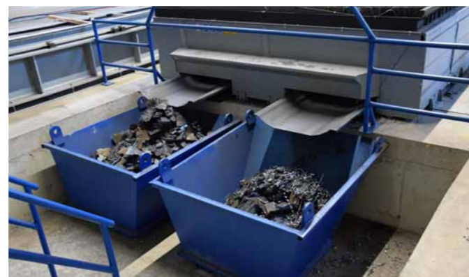
Heute: ZINTRAC mit automatischer Schlackeentsorgung
